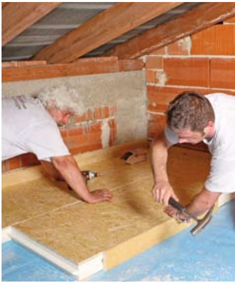
Dämmung der obersten Geschossdecke mit BauderPIR DHW z.B. auf Betondecke
